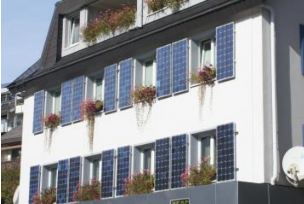
Photovoltaik an der Fassade, Bild: Energieagentur Regio Freiburg GmbH
